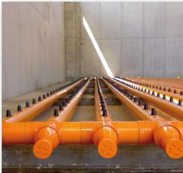
*Sistema di insufflazione a pavimento*
